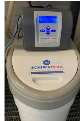
Installation einer Brauchwasserentkalkungsanlage zur Fahrzeugreinigung
